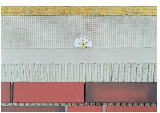
После затвердевания раствора RKS/KMR наносится первый слой **Базового штукатурного** состава для СФТК RAS толщиной ~ 5 мм. В него с помощью гладилки слегка утапливается усиленная **Армирующая сетка PUG.** Затем поверх сетки наносят второй слой армирующего раствора RAS толщиной ~ 2 мм. Общая толщина армирующего слоя должна составлять минимум 7 мм (максимум 10 мм).
