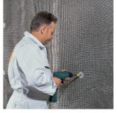
Затем через армирующую сетку РUG плиты крепят тарельчатыми дюбелями LOBATHERM и головки дюбелей шпаклюют RAS способом «мокрое по мокрому». Минимальная общая толщина армирующего слоя составляет 7 мм.
