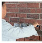
Швы открытопористых плиток заделывают Раствором для заполнения швов RFS с помощью расшивкой и ...
