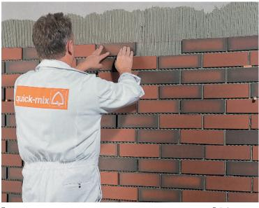
После полного затвердевания армирующего слоя приклеивают плитки методом «Buttering-Floating»: зубчатым шпателем (10х10 мм) наносят слой RKS на поверхность основания, в который вдавливают плитки, покрытые миллиметровым слоем RKS с изнаночной стороны.
