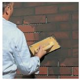
Швы закрытопористых плиток затирают Раствором-шламом RSS (точно так же как и кафельные плитки) с помощью губчатого шпателя ...
