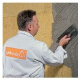
На теплоизоляционные плиты, в данном случае – минераловатные, приклеенные Клеящим раствором для керамической плитки RKS, наносят первый слой армирующего раствора RAS или KMR толщиной ~ 5 мм. В него с помощью утолщенная Армирующая сетка PUG.
